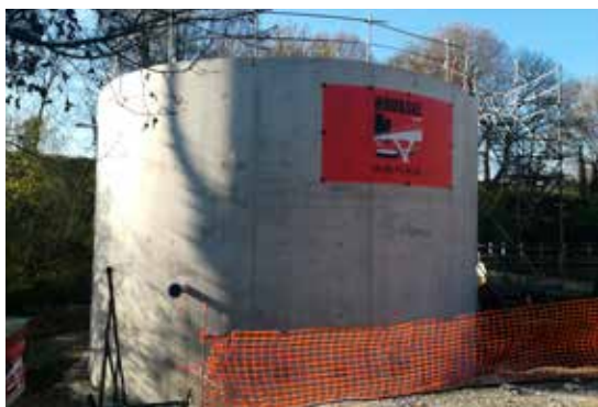
Réhabilitation station d'épuration de Plouha, boue activée - nouveau silo à boues
